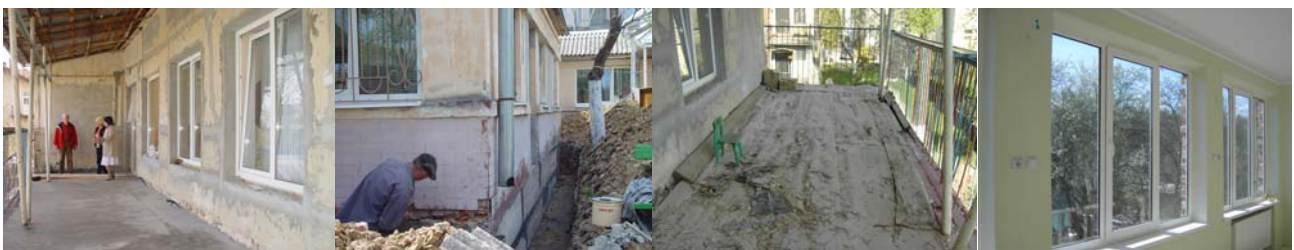
Nu het balkon nog, waar de kinderen in bedjes buiten staan als het goed weer is
